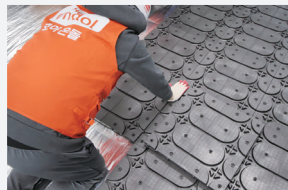
호야온돌 하판 설치
