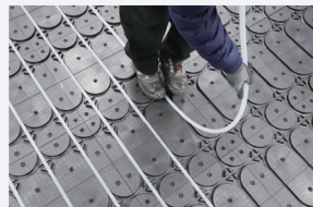
온수 파이프 설치
